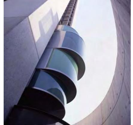
*La composición cruciforme de la planta posibilita su construcción mediante cuatro prismas formados por elementos prefabricados de hormigón, que albergan los recorridos de los tres ascensores y la escalera, permitiendo conseguir la máxima esbeltez mediante la reducción al mínimo de la superficie en planta, y el logro de un fuste columnario complejo que posibilite un juego de luces, sombras y perspectivas diversas, subrayando dicha esbeltez.*
