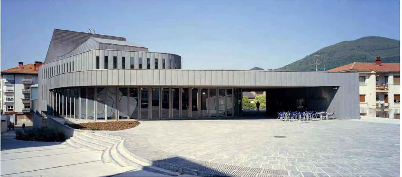
*.El edificio se organiza a partir del escenario de la sala principal, situado en la cota más baja del solar para permitir el desarrollo del graderío de butacas de acuerdo con el desnivel del terreno, en dos tramos de diferente pendiente. Rodeando el vacío del escenario se disponen, a distintas alturas y en forma de "U", tanto los espacios de apoyo al escenario como los propios de la Escuela de Música y del Área Administrativa.*
