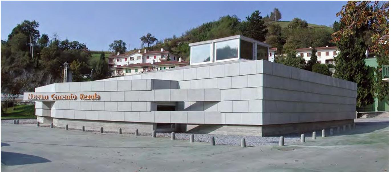
*Se plantea la construcción de una nueva fachada, exterior al pórtico perimetral y separada de él, que se propone ciega con el objeto de ofrecer una superficie adecuada a la exposición perimetral, pero también para reforzar la calidad escenográfica de centralidad derivada de la apertura del lucernario cenital.*
